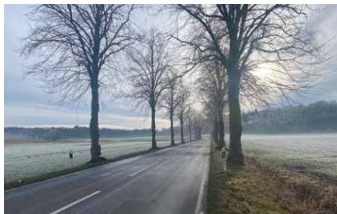
An der L87 zwischen Schledehausen und Wulften soll bald ein Bürgeradweg für mehr Sicherheit sorgen.
