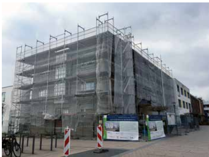
Die Sanierungsarbeiten am Rathaus kommen gut voran.
