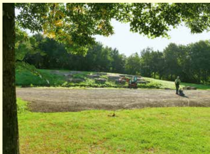
Vor der neuen Naturtribüne wird die befestigte künftige Schotterfläche noch eingesät und wird Platz für Bühne und Aktionen bieten.
